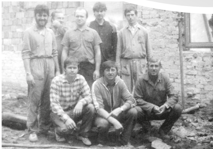
BUDOVÁNÍ ČTYŘDRÁHY, srpen 1987
